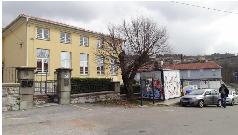
Slika 1. Pogled na južno pročelje
