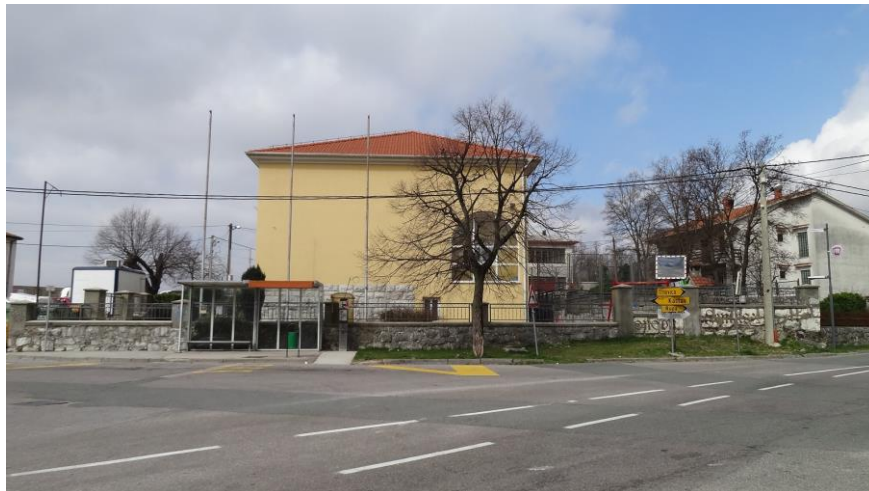
Slika 2. Pogled na istočno pročelje
