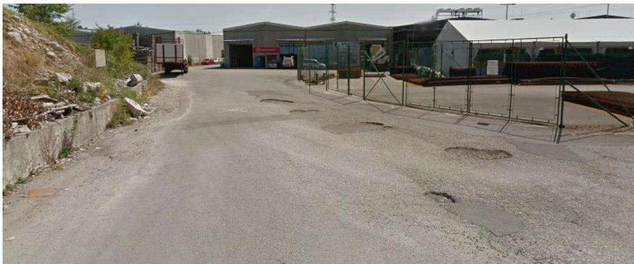
Slika 3. Oštećenja kolnika
