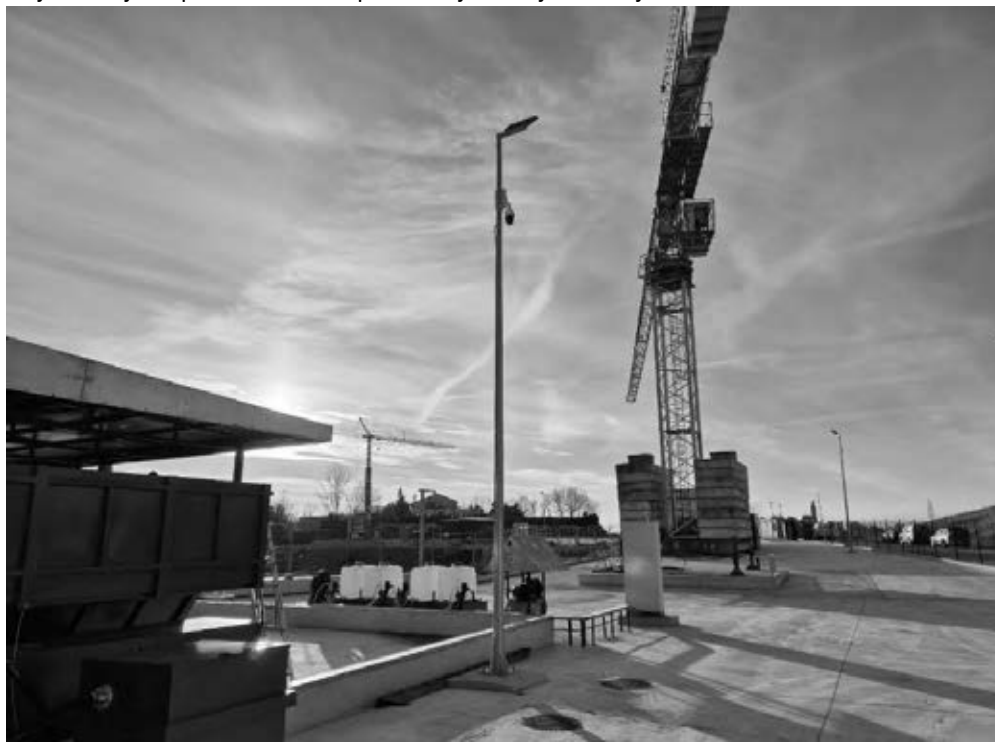
Slika 22: Sanacija jame Sovjak - Etapa I
