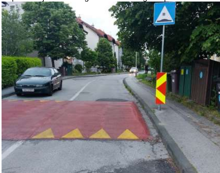
Načelni izgled izvedene uzdignute plohe (Zagreb)
