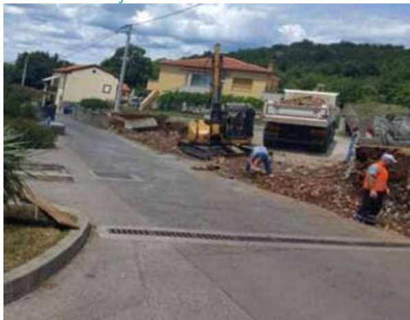
Slika 18. Sanacija ceste u Petrcima
