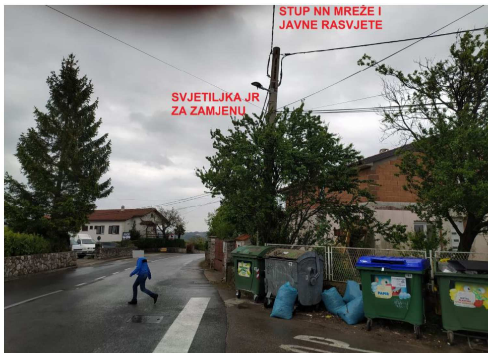
Slika 6. Postojeći stup za postavljanje elektro-ormarića
