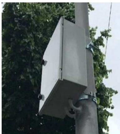
Slika 7. Primjer postavljanja razvodnog ormarića
