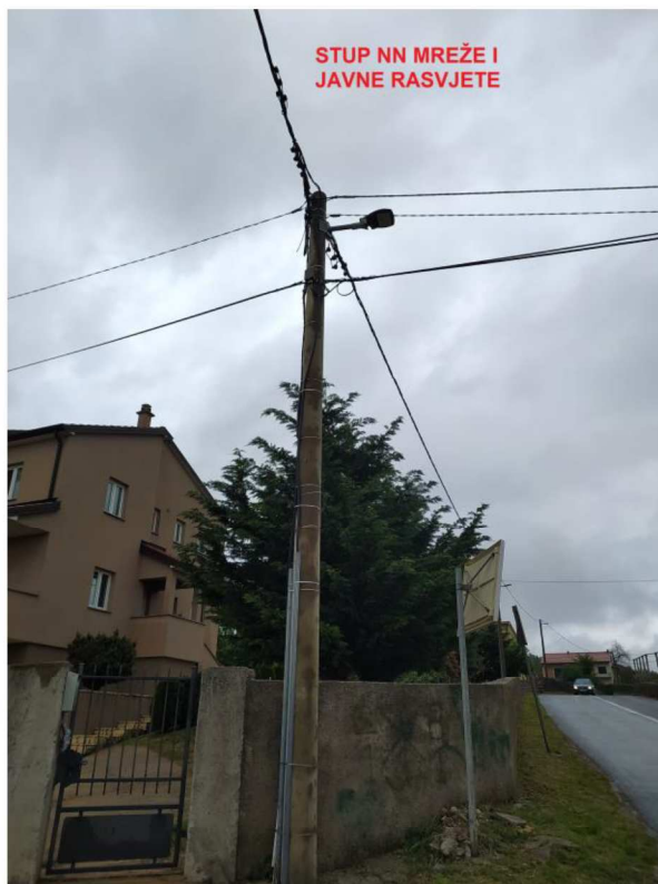
Slika 4. Postojeći stup za moguće napajanje radara el.energijom
