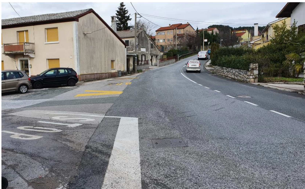
Slika 2. Postojeće autobusno stajalište na raskrižju (proj.stac. 0+080.00)
